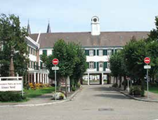
Die Anstalt Stephansfeld in Brumath bei Straßburg (Eingangsbereich, aktuelle Ansicht)
